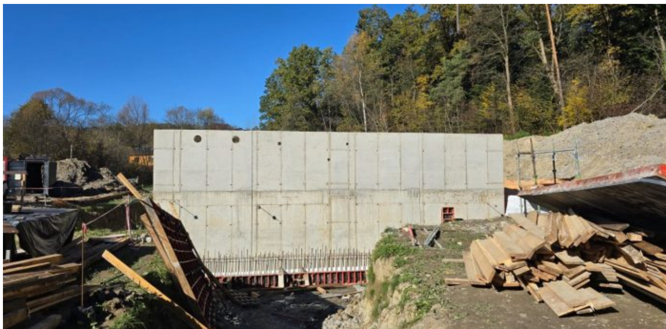
Łęka: budowa oczyszczalni ścieków
