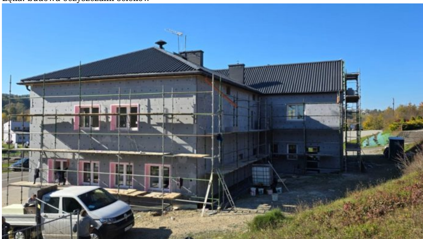
Wojnarowa: termomodernizacja remizy
