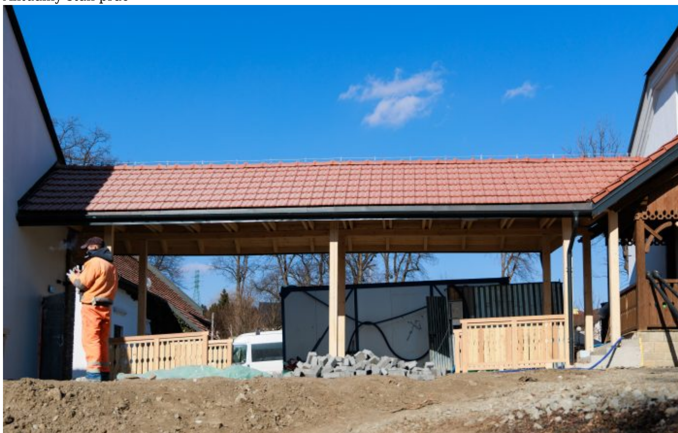
Aktualny stan prac
