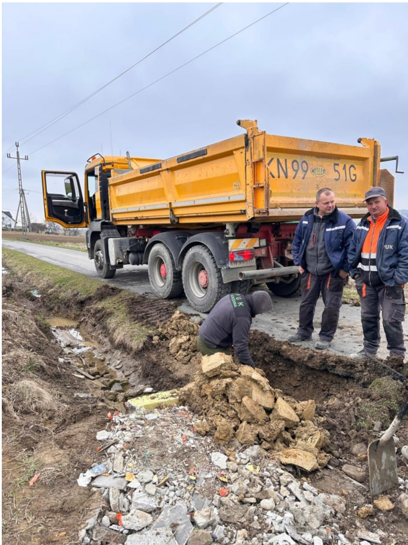
Droga Miłkowa Na Bagnach - początek modernizacji.
