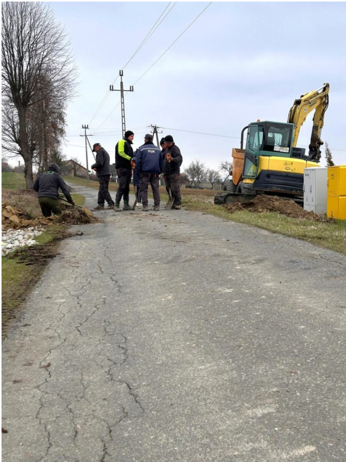
Tagi: Miłkowa , PUK , inwestycja , modernizacja , nawierzchnia betonowa , remont drogi , roboty
