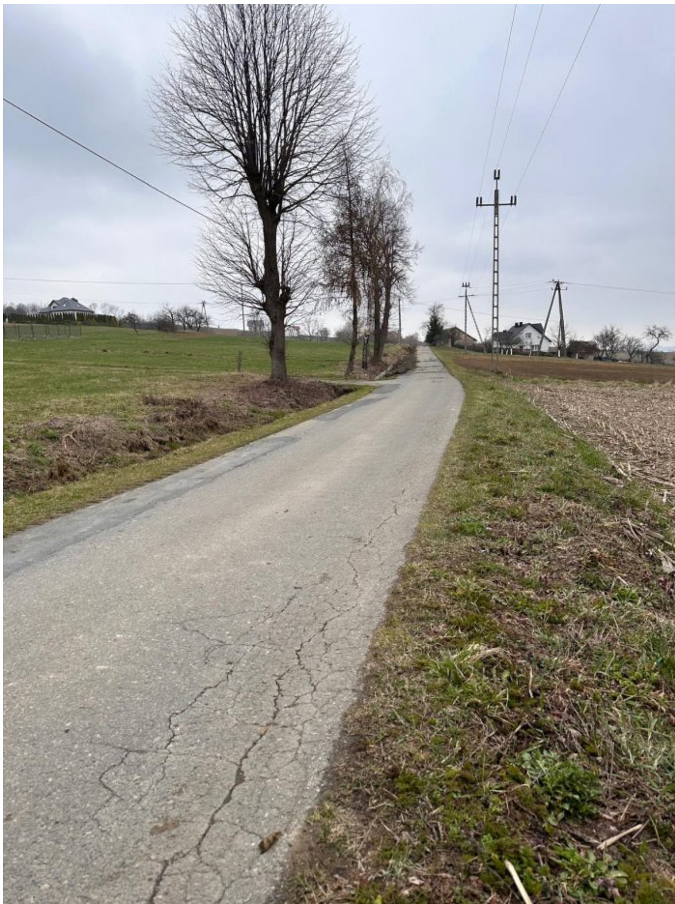
Trwa remont w Miłkowej
